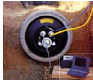
Prüfblase im Einsatz
